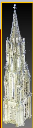
Les quarante-trois stations de scans réalisées sur place ont été ensuite assemblées pour former un **nuage de points global** de la flèche, avec une précision de 2 mm. Des sphères ont été utilisées lors de la numérisation afin de faciliter l'assemblage final.
