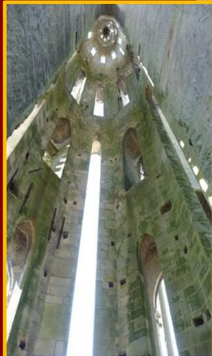
Érigée vers 1230, la flèche se compose d'un octogone de 15 mètres de haut, surmonté d'une pyramide de 26 mètres. L'objectif principal du projet ModeFSenlis est de comprendre **comment cette structure culminant à près de 80 mètres a été bâtie**. Les trous utilisés pour monter les échafaudages du Moyen Âge, appelés « **trous de boulin** », constituent de précieux indices, pouvant être mesurés et reliés grâce aux techniques numériques.
